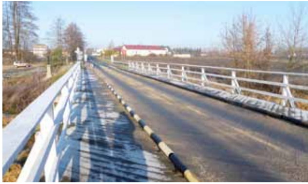
Most w Kompinie ma drewnianą konstrukcję oraz poszycie.
