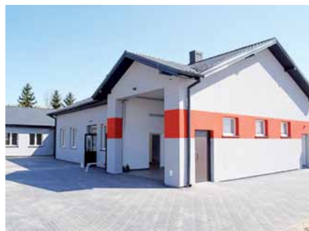
Widok na obiekt od strony nowo dobudowanej części i garażu.
