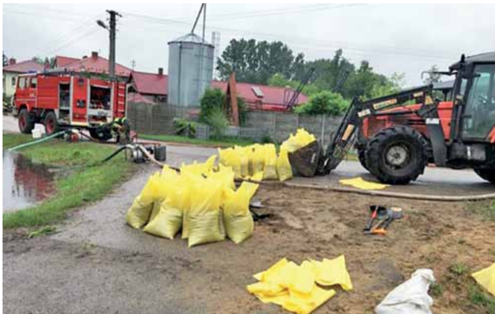
Strażacy robią wszystko, aby ochronić przed zalaniem posesje mieszkańców. W tym celu 24 czerwca w Bobrownikach ustawili m.in. zapory z worków z piaskiem.
