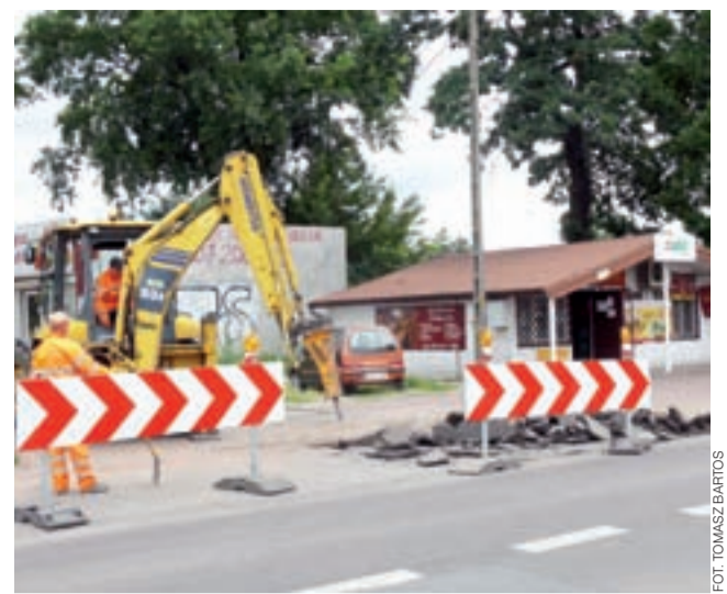
Prace na wjeździe w drogę wiodącą na osiedle M. Konopnickiej od ul. Bolimowskiej.
