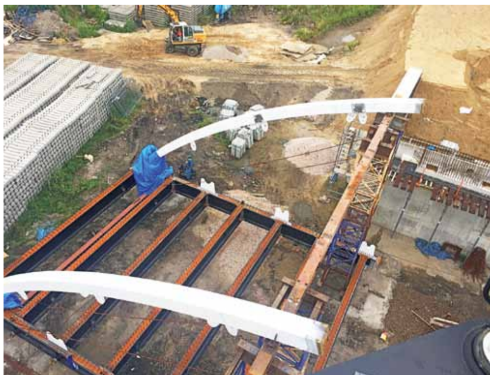
Tak wyglądał pierwszy segment konstrukcji łukowej wraz z elementami jezdni w ubiegłym tygodniu...
