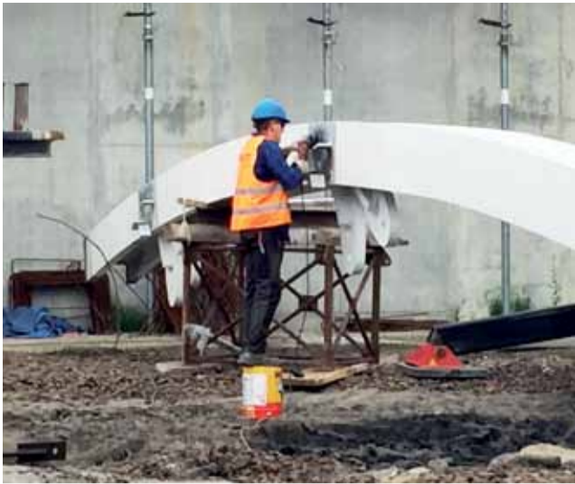
Praca w tak wygodnej pozycji i na tak niewielkiej wysokości to na tej budowie rzadkość.
