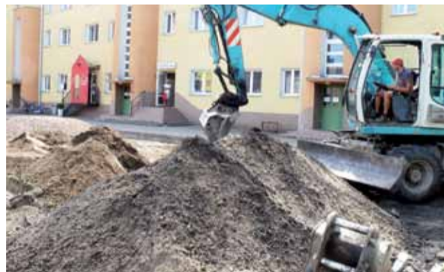
Pracownicy firmy Wig-Kost w trakcie demontażu starej nawierzchni przed blokiem nr 2 na os. Bratkowice.
