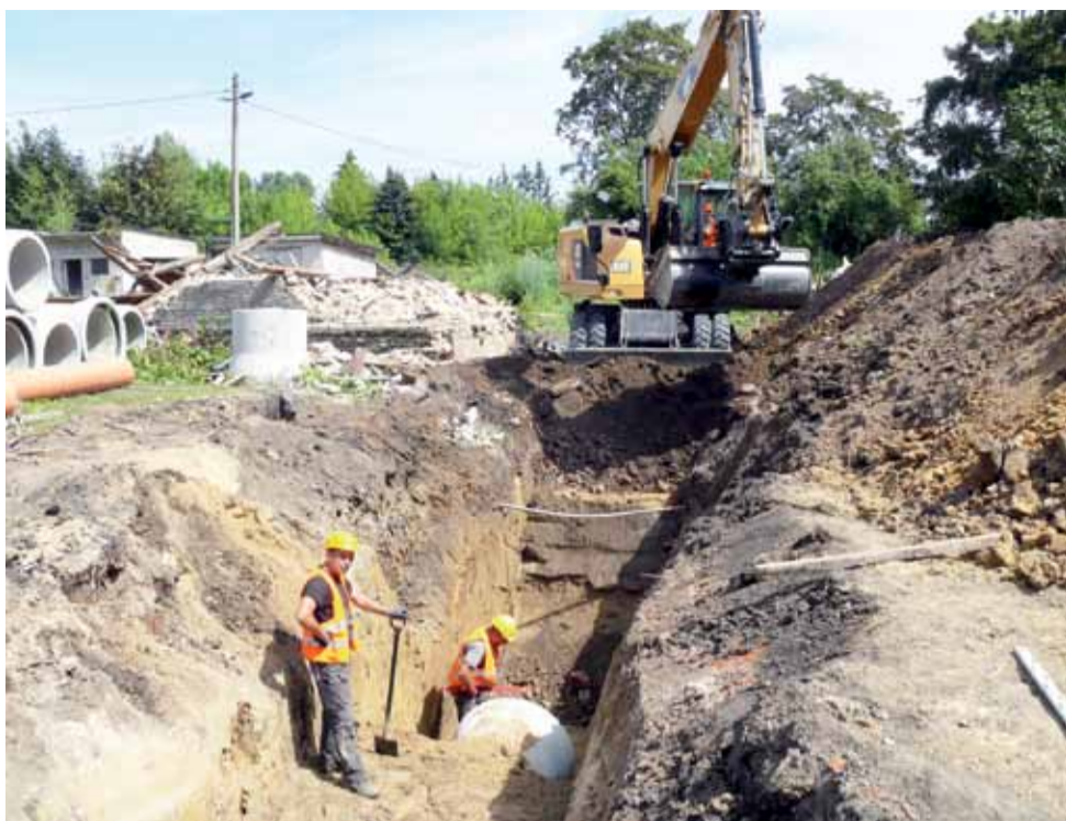
Kutnowska firma Trakt rozpoczęła budowę kanalizacji deszczowej w śladzie drogi w kierunku wiaduktu.
