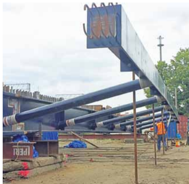
Boczna część jezdni. Na niej powstanie chodnik.
