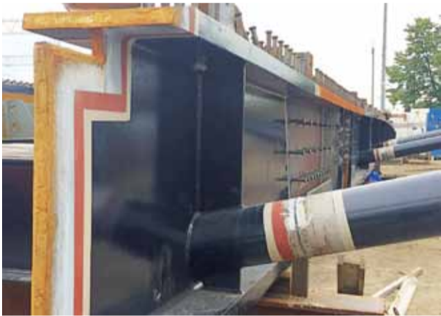
Na elementach gotowych widać iloma warstwami substancji ochronnych są pokryte. Spawy będą tak samo konserwowane.
