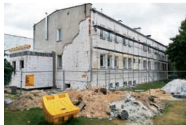
Jeden z modernizowanych bloków przy Armii Krajowej nr 43, widać już dobudowywane pomieszczenie kotłowni.
