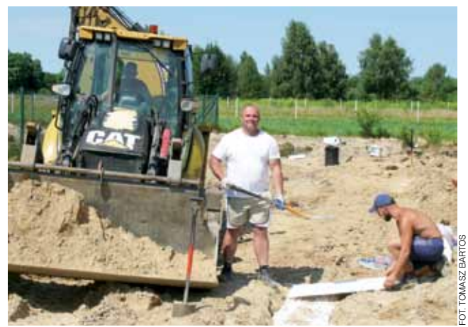
Pracownicy łowickiej firmy Cewogaz przy zasypywaniu drenażu na terenie SP w Bobrownikach.
