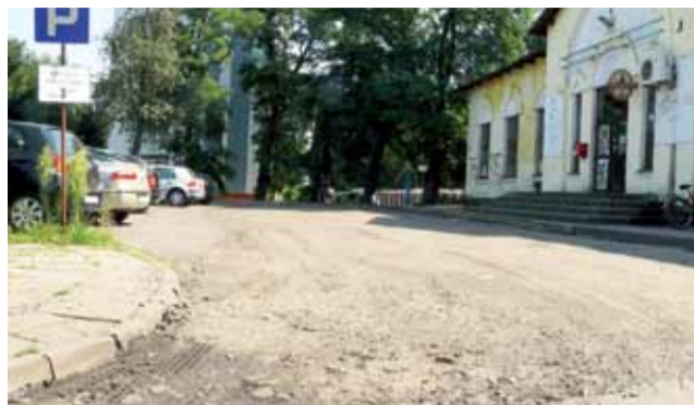
Asfalt przed dworcem został sfrezowany, wygląda to jeszcze gorzej niż było, ale ratusz zapowiada zmiany na lepsze.
