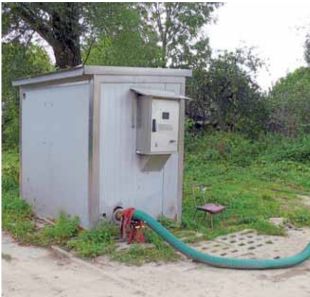
Punkt zlewny ścieków z szamba, które przywożone są przez wozy asenizacyjne na łowickiej oczyszczalni.
