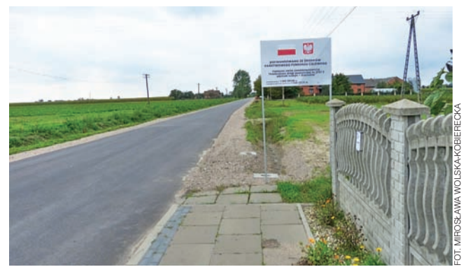
Droga Luszyn – Kiernoza została wyremontowana na odcinku 6760 m, kosztem 1,5 mln zł.
