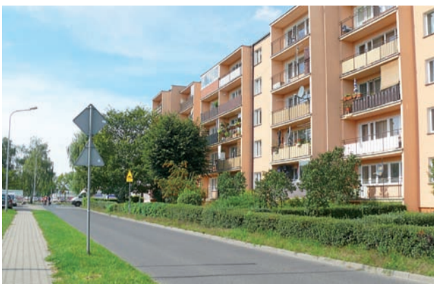
Blok nr 24 na osiedlu Bratkowice – do końca listopada w miejscu żywoplotu powstanie chodnik.
