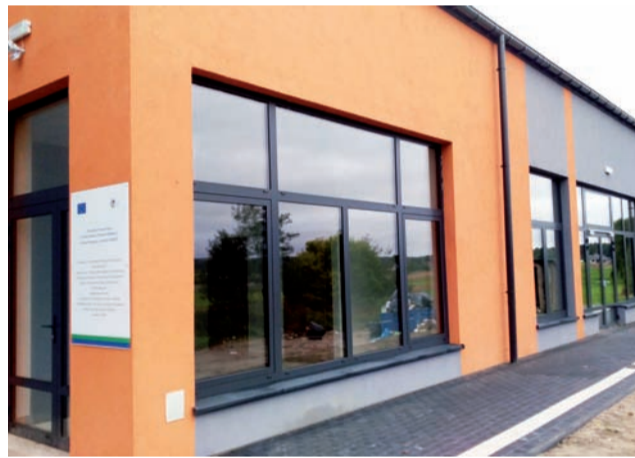
Dobudowana część ośrodka kultury prezentuje się z zewnątrz lepiej niż od strony wejścia głównego.
