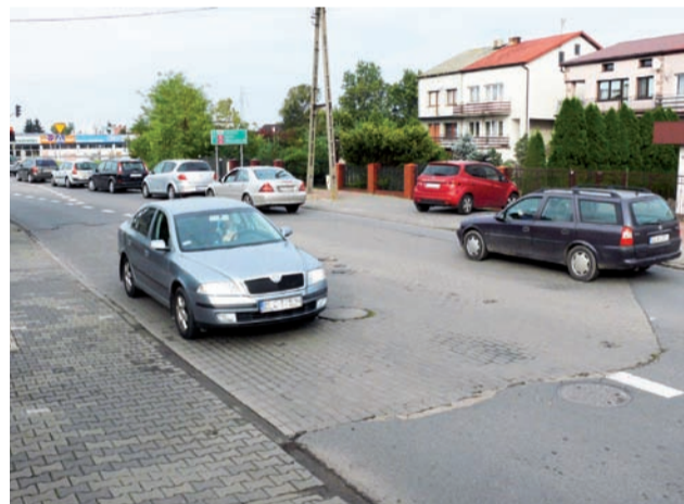
Pracownicy ZUM mają poprawić kostkę w miejscu gdzie zainstalowano separator.
