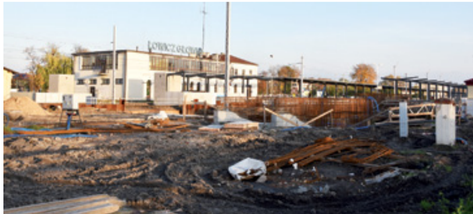
Teren stacji Łowicz Główny od bardzo dawna jest placem budowy.
