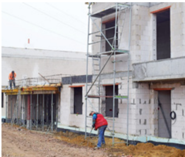
Postęp prac na budowie osiedla w zeszłą sobotę.
