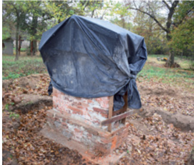
Nagrobek w trakcie renowacji, pod koniec ubiegłego tygodnia.
