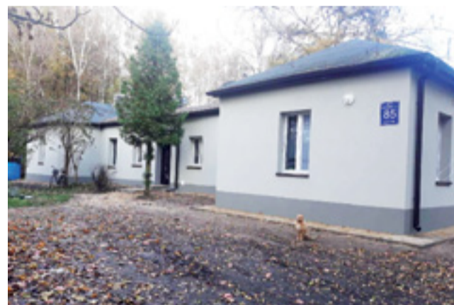
Budynek przy ul. Łyszkowickiej 85 po remoncie.
