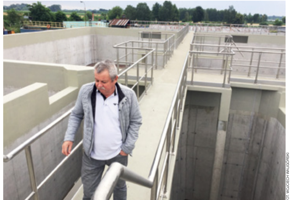
Najdroższa miejska inwestycja w tym roku: nowa oczyszczalnia ścieków. Na tle nowych zbiorników jej kierownik Cezary Kołodziejki.
