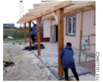
Zakończyła się budowa drewnianego ganku przy Domu Ludowym w Zabostowie Dużym.
