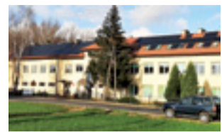
Panele fotowoltaiczne już zostały zamontowane na Szkole Podstawowej w Kocierzewie Płd.
