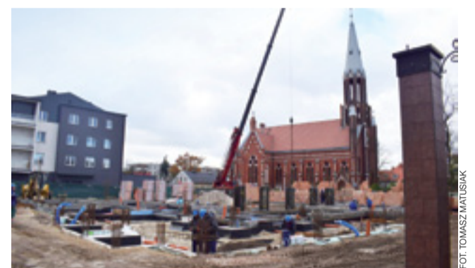
Szybko postępuje budowa wielorodzinnego budynku mieszkalno-usługowego przy Alejach Sienkiewicza w Łowiczu, w miejscu po wyburzonym głównym gmachu Mazowieckiej Wyższej Szkoły Humanistyczno-Pedagogicznej. Po wylaniu fundamentów ruszyły teraz prace murarskie. Obiekt, wraz z miejscami parkingowymi, ma być gotowy do końca przyszłego roku. tm
