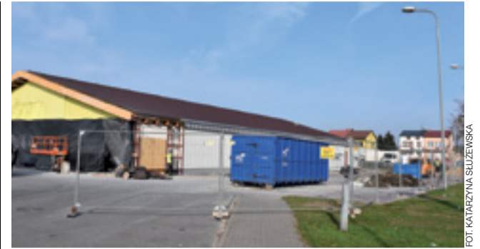
Trwa remont Biedronki na ul. Łęczyskiej w Łowiczu.
