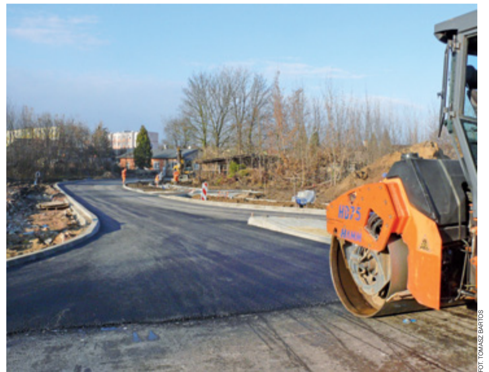
Na tym zdjęciu widzimy fragment drogi, która połączy wjazd na wiadukt z ulicą 3 Maja.
