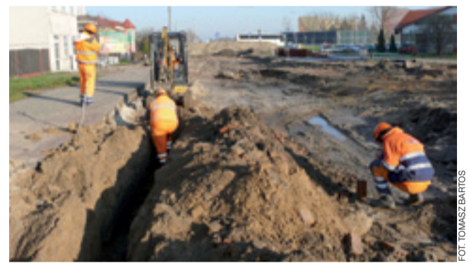
Prace przy budowie wiaduktu kolejowego na odcinku ulicy Warszawskiej.
