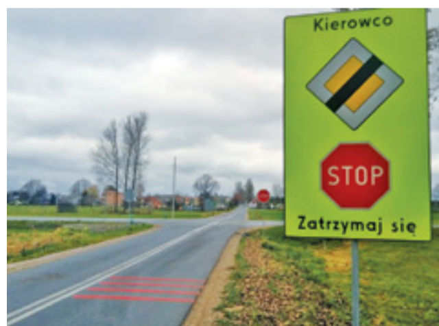
Znaki i pasy wibracyjne zostały zamontowane w ostatnich dniach.
