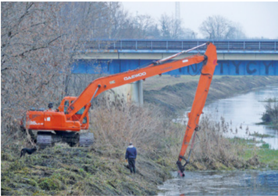
Wybieranie z koryta Bzury roślin przez koparkę okazało się śmiertelnie niebezpieczne dla ryb. Na zdjęciu prace na wysokości zakładu energetycznego w Łowiczu.
