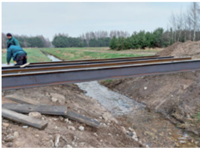
Nowy most w Karolewie będzie solidniejszy od poprzednika – zastosowano w nim szersze i grubsze tegry.
