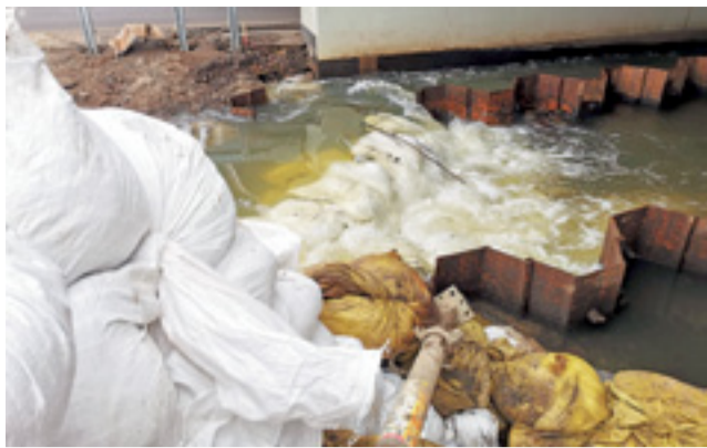
Na zdjęciu worki zgromadzone przy rzece, tama i ściany Larsena pod mostem.
