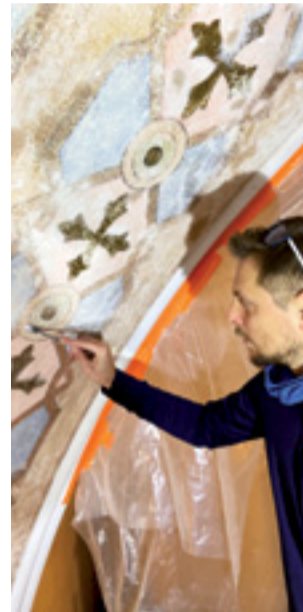
Pod czterema warstwami farby odkryto w kościele w Zdunach ciekawe freski. Prace trwają.
