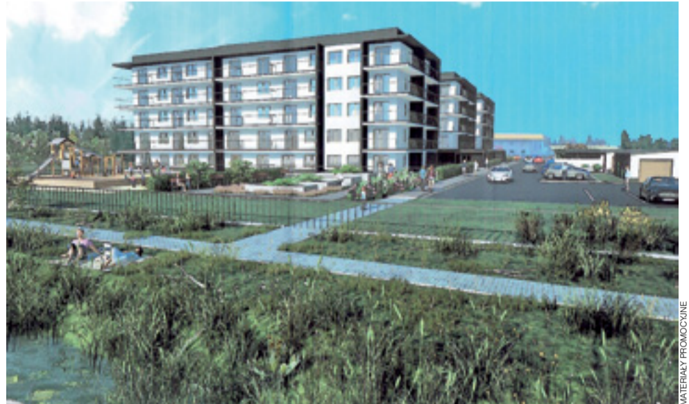
Tak mogą wyglądać bloki mieszkalne przy ul. Nadburzańskiej Dolnej, w miejscu, gdzie była dawna rzeźnia miejska.
