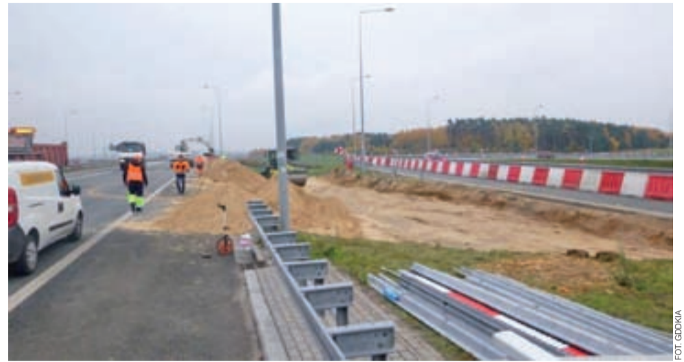
Tak w listopadzie 2019 r. budowano tymczasowy objazd. Teraz na czas prób nawet i on nie jest dostępny.
