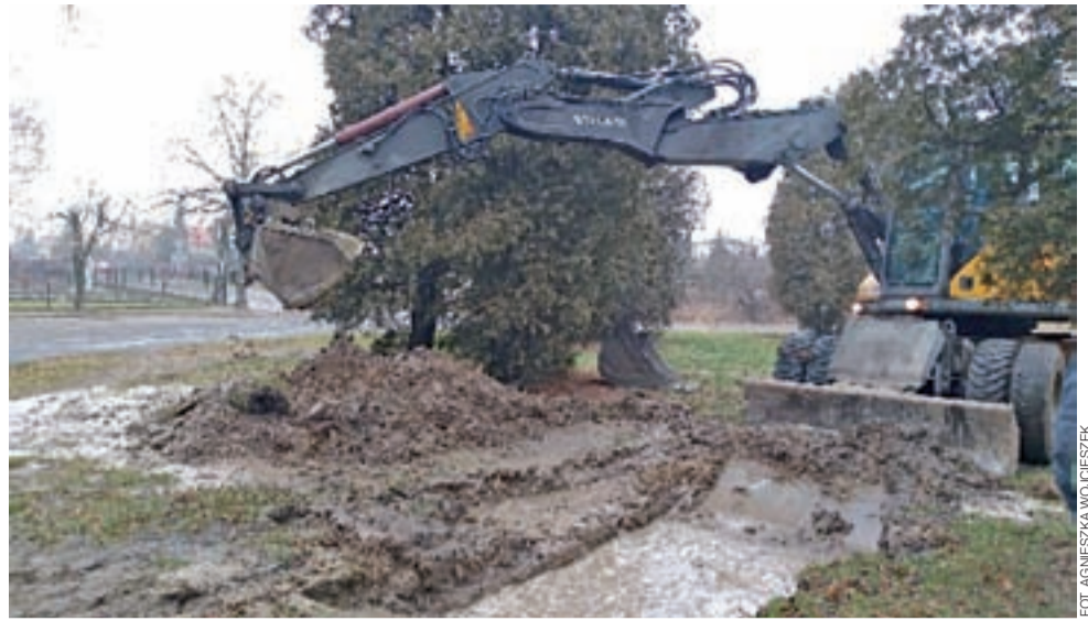
Usuwanie awarii wodociągowej na rondzie przy SP nr 1 w Głownie.
