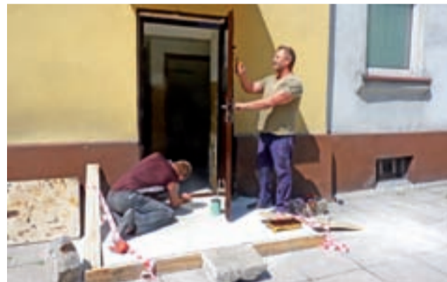
Latem wymieniano drzwi wejściowe i robiono nowe podesty w bloku Narutowicza 79, w którym zrobiono również centralne ogrzewanie.
