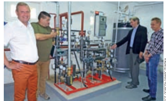
W sierpniu zamontowano nowy dwufunkcyjny węzeł ciepłowniczy w bloku Konopnickiej 5a.
