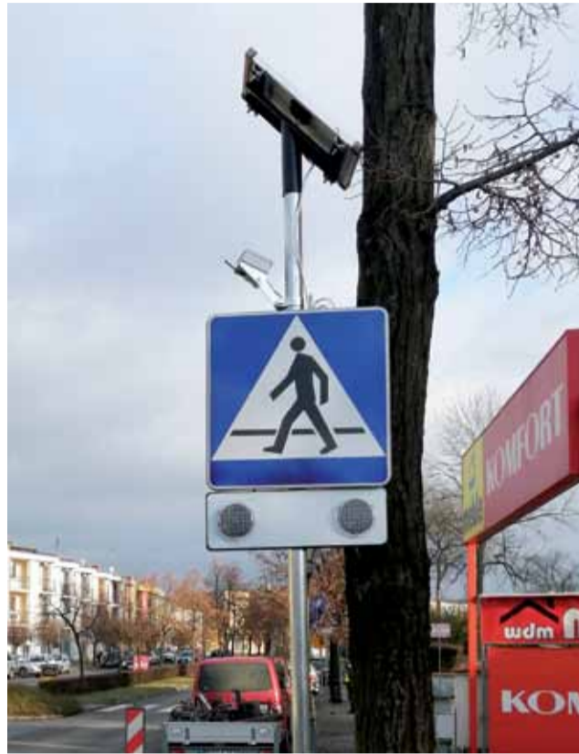
Drzewo zasłania panel fotowoltaiczny – nie będzie się dobrze ładował.
