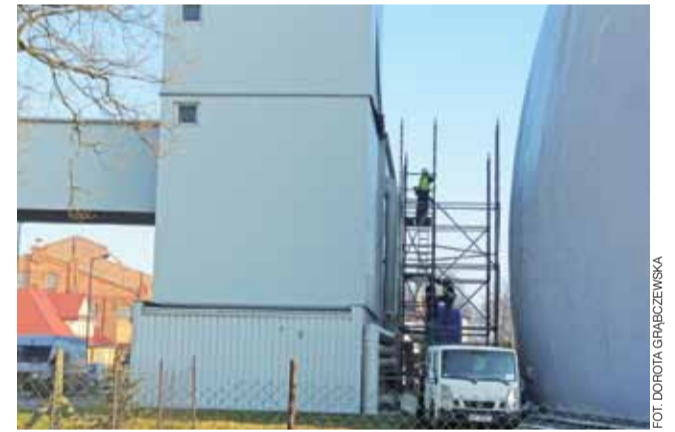
W piątek 17 stycznia specjalistyczna firma naprawiała ostatni, trzeci element uszkodzonej blachy, po wybuchu pyłu cukrowego
