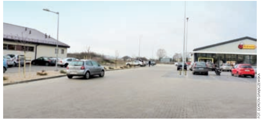
Na terenie pomiędzy Dino i nową Biedronką, gdzie teraz rosną krzaki, wkrótce ma powstać 5-stanowiskowa myjnia bezdotykowa.
