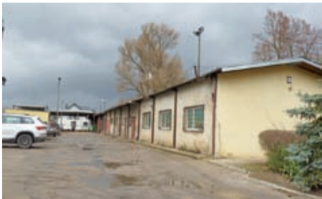
Po likwidacji spółki gminnej Mig-Ma majątek spółki przejdzie na gminę. Już teraz się mówi, że budynki zostaną sprzedane.
