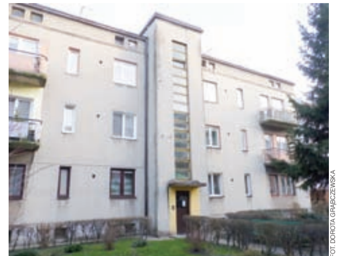
Wkrótce rozpoczną się prace przy przebudowie oszklonego korytarza. Część okien zostanie zamurowana.
