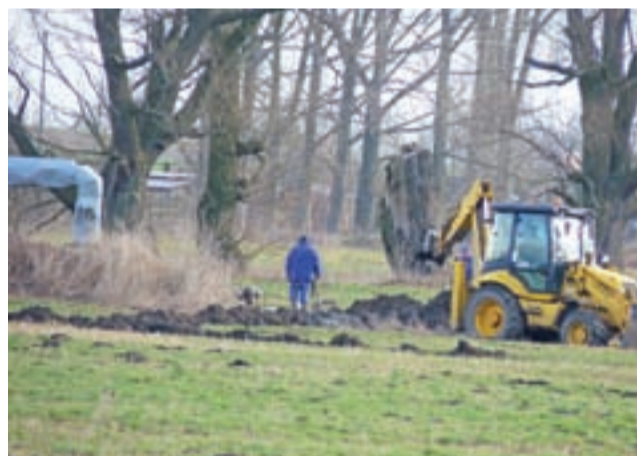
W poniedziałek pracownicy PWiK usuwali awarię wodociągu o średnicy 200 m zasilającego osiedle Wyzwolenia w wodę pitną. Wcześniej przez trzy dni osuszali teren, by wjechać ciężkim sprzętem.
