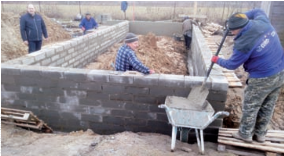
Widać już powstające mury nowej świetlicy. Radny Jarosław Włodarczyk jest na placu budowy prawie codziennie.
