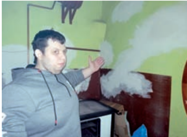
Damian Warowicki pokazuje ścianę po naprawie przez pracowników ekipy remontowej ZGM.
