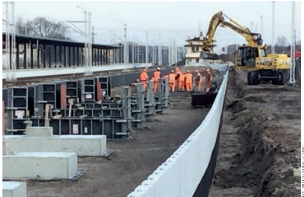
Prace na peronie 2. Widać południową ściankę peronu i fundamenty pod filary wiaty.
