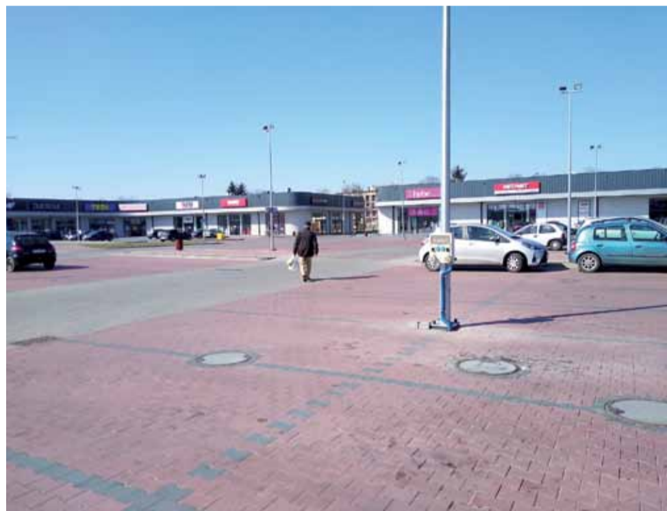
Park handlowy STOP SHOP: otwartych jest jedynie kilka sklepów, a parking stoi pusty.
