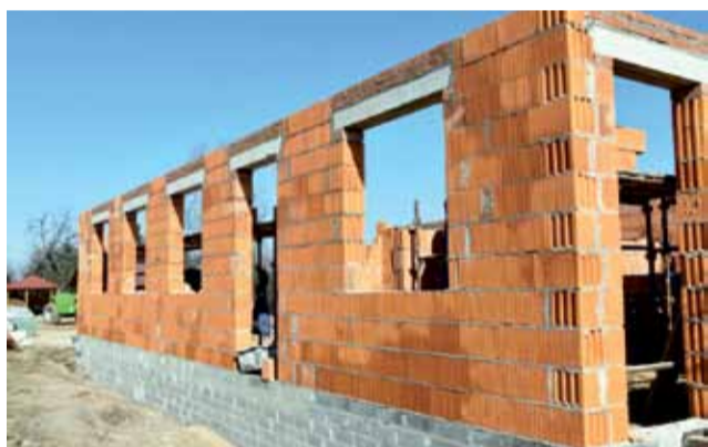
Budowa świetlicy w Wysokach może zostać zakończona przed terminem.
