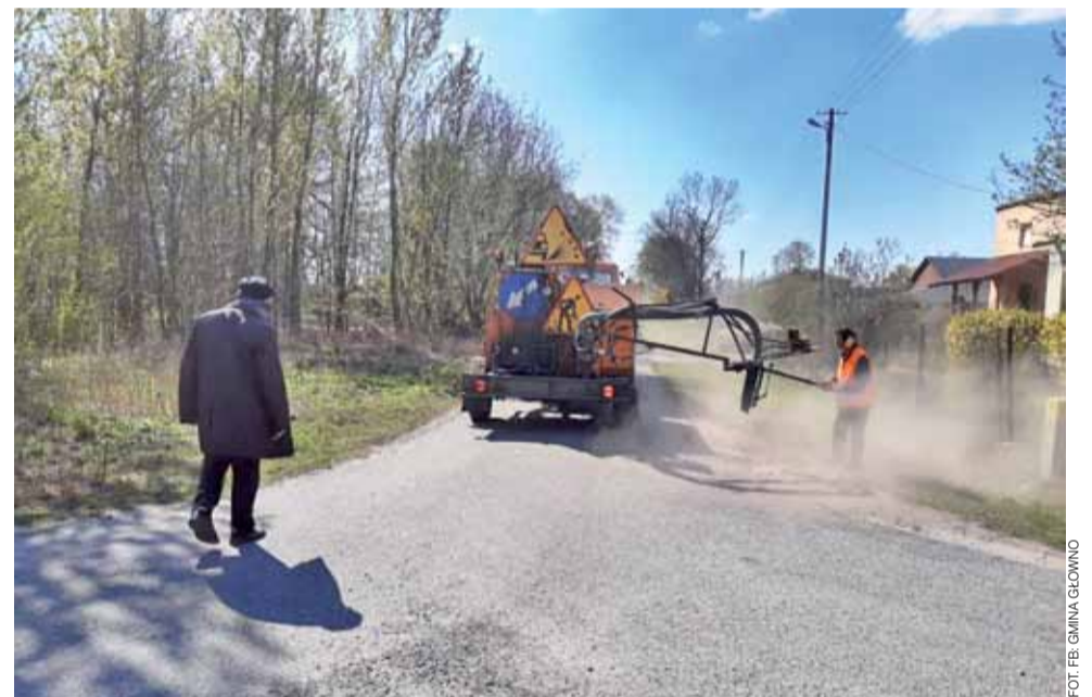
Działania w toku. Dzięki nim przejazd drogami gminnymi niebawem będzie łatwiejszy.
