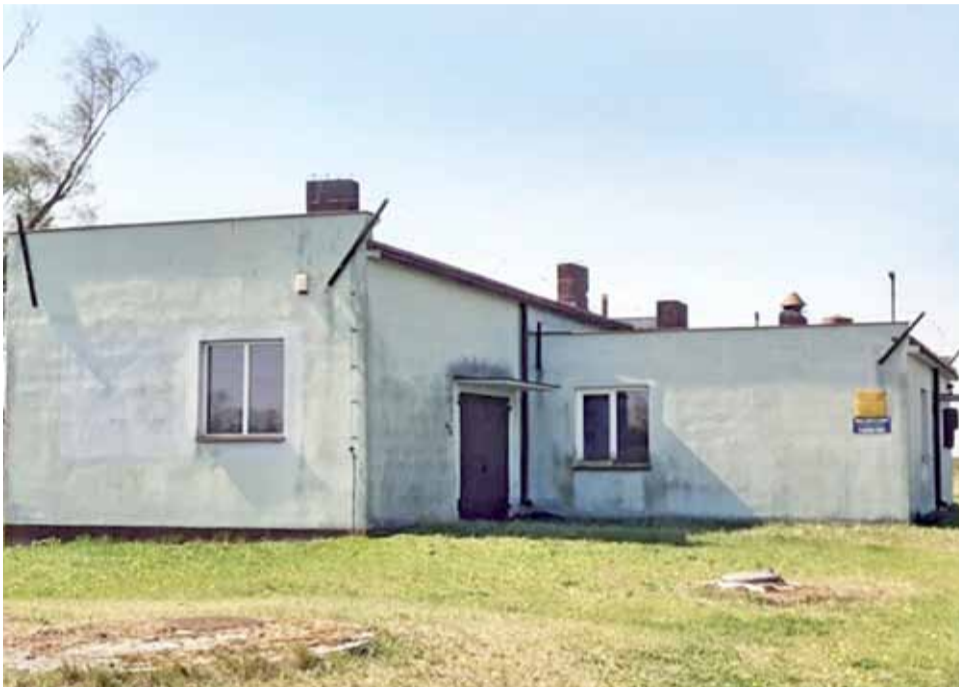
Pośród zaplanowanych w tym roku na terenie gminy Głowno inwestycji jest modernizacja stacji uzdatniania wody (wraz z wymianą zbiorników i złóż) w Boczkach Domaradzkich. Jest to jedna z kluczowych inwestycji zaplanowanych w bieżącym roku na terenie Gminy Głowno.
