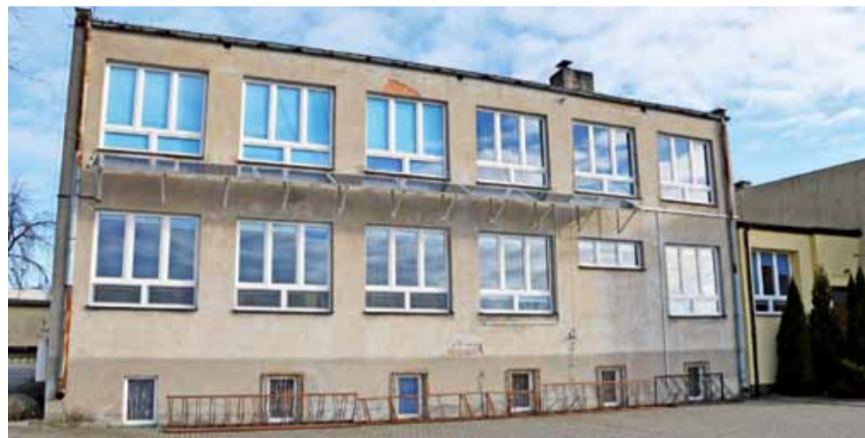
Budynek SP 2 w Strykowie przed planowaną termomodernizacją.
