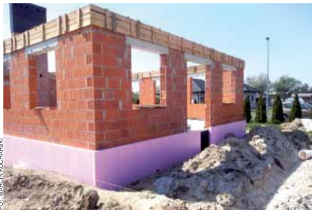
Tak teraz prezentuje się budowa świetlicy w Wyskokach.
