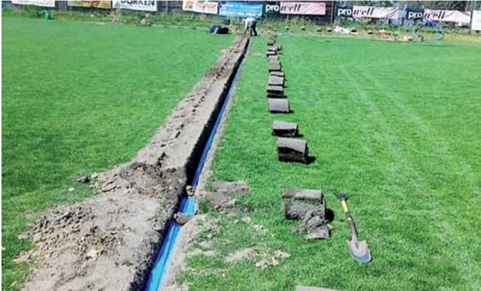
Prace renowacyjne na boisku w Strykowie. Zjednoczeni doczekali się automatycznego systemu nawadniania, co pozwoli na znaczne oszczędności wody, pieniędzy i czasu.
