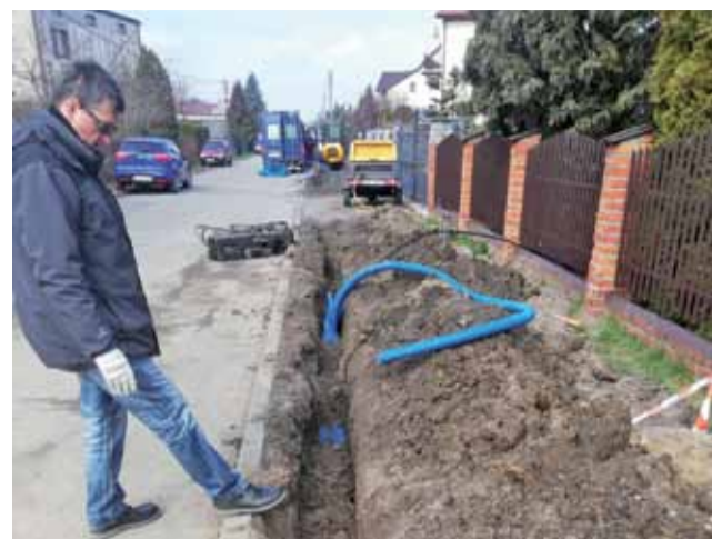
Budowa oświetlenia ulicznego w Tymbiance.
