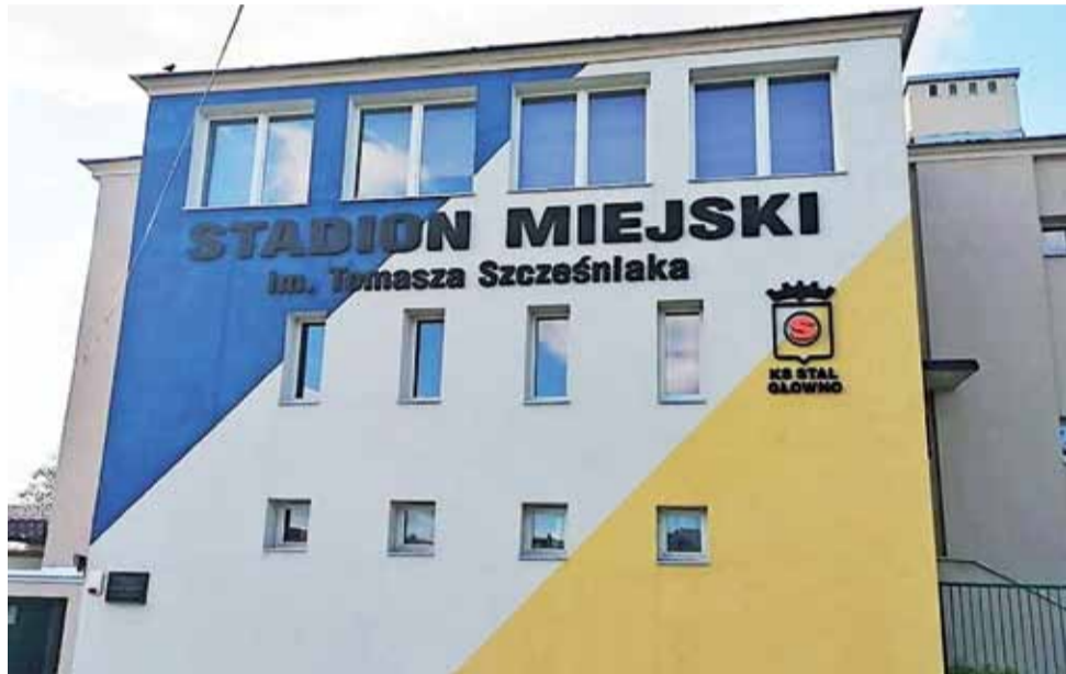
Nowa elewacja na budynku klubowym Stali Głowno przy ul. Kopernika 37 robi wrażenie.
