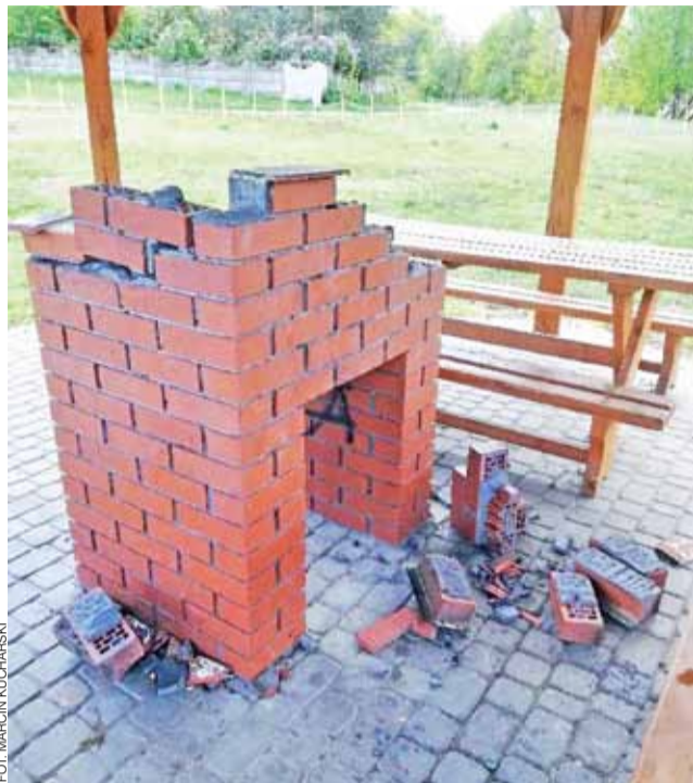
Grill w altanie w okolicy ul. Piażowej w Głownie został zniszczony po raz kolejny.
