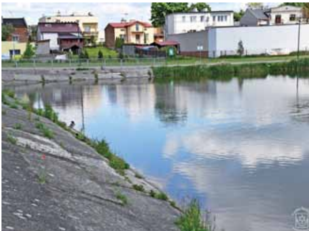
Remontu wymagają m.in. betonowe umocnienia skarp.
