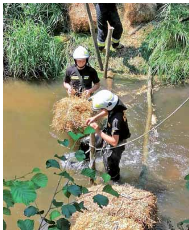
Strażacy podczas ustawiania tam z belek słomy na Mrodze przepływającej przez teren gminy Dmosin.
