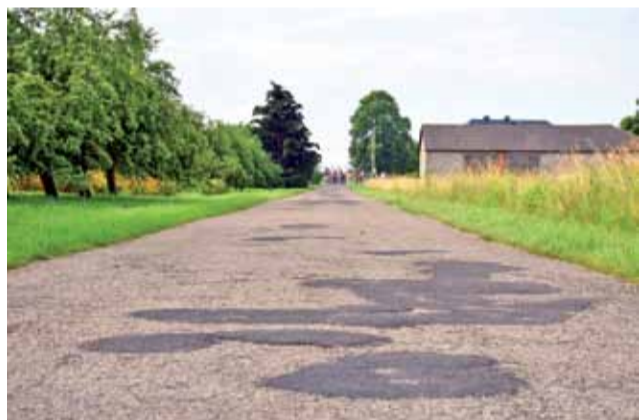
Gmina otrzymała z sejmiku wojewódzkiego dotację na remont drogi w Wyskokach.
