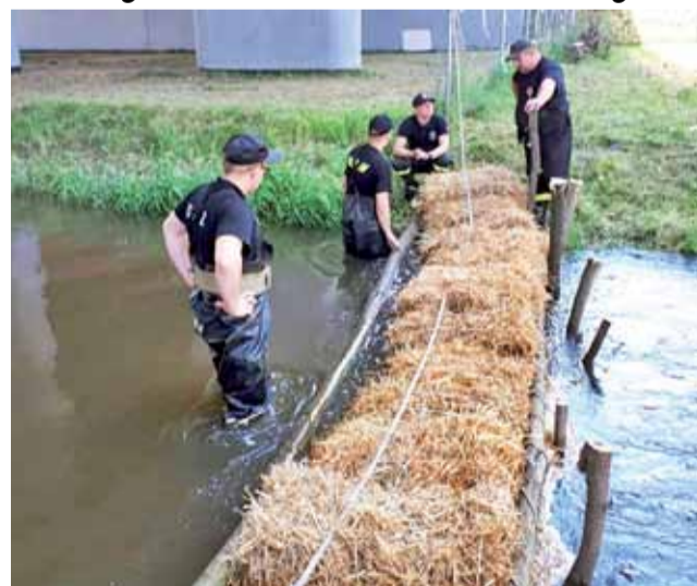
Strażacy podczas ustawiania tamy z belek słomy na Mrodze przepływającej przez teren gminy Dmosin.
