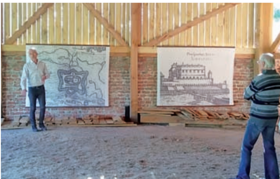
Historyczne rysunki przedstawiające zamek eksponowane są w miejscu domu wysokiego, którego ocalałe mury zabezpieczone są drewnianą, zadaszoną konstrukcją.
