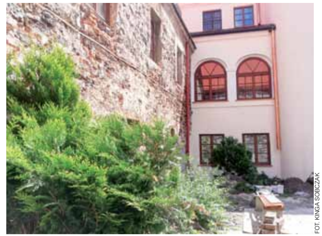
Nieotynkowany – na razie – mur w wewnętrznym dziedzińcu szkoły.
