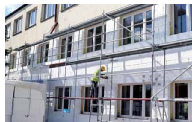
Również pracownicy na placu budowy zapewniali nas, że prace przebiegają sprawnie, bez większych trudności.
