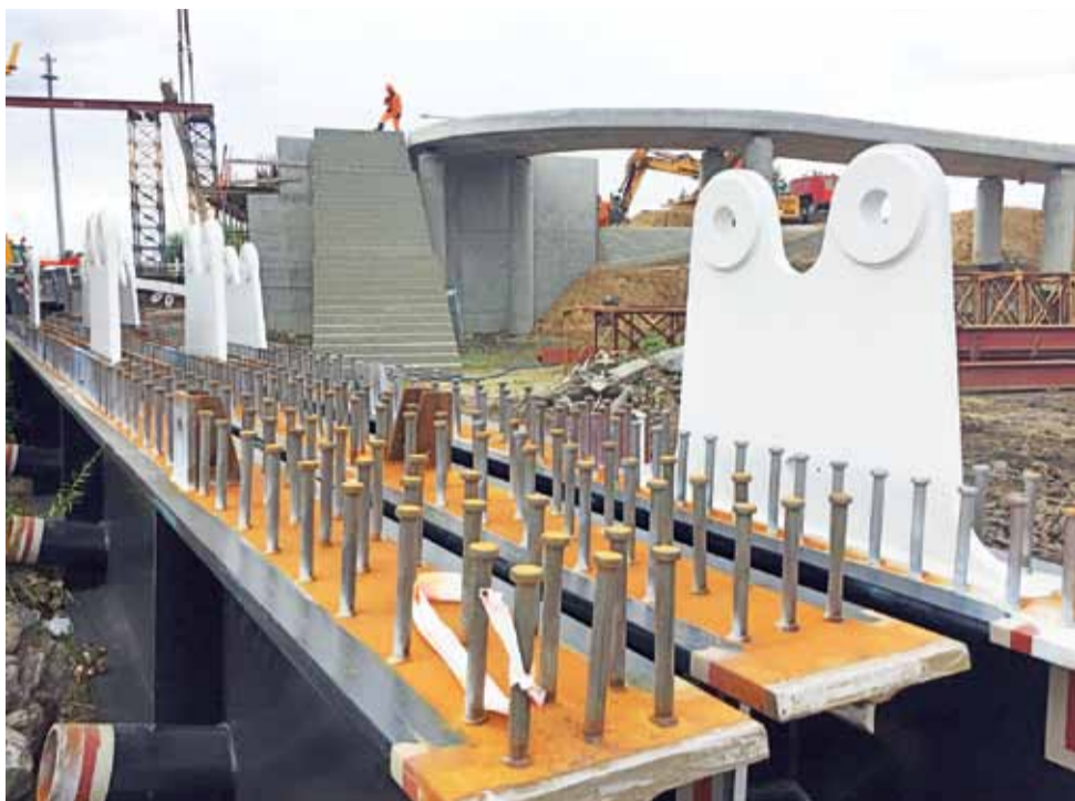
Belki przyszłej jezdni. Widać zaczepy lin nośnych.
