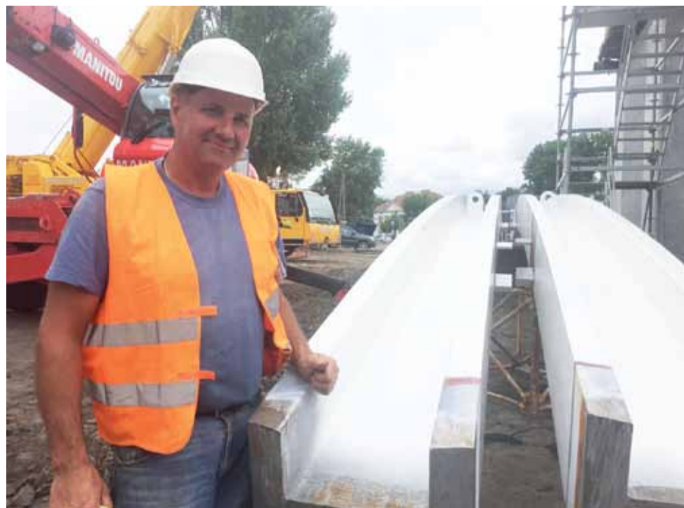
Brygadzysta Bogusław Broda przy elementach nośnego łuku. W WKS pracuje od 31 lat.
