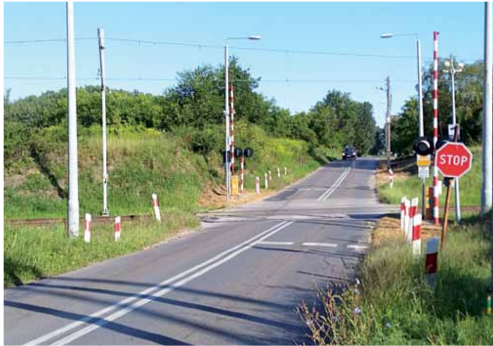
Przejazd przy ul. Bielawskiej. W takich miejscach kierowcy powinni zachować szczególną ostrożność niezależnie od sprawności systemu bezpieczeństwa.
