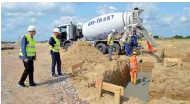
Inwestycja rozpoczęła się w lipcu 2017 r. Na placu budowy w sierpniu. Zarząd „Bzury” i przedstawiciel wykonawcy z inspektorem nadzoru.
