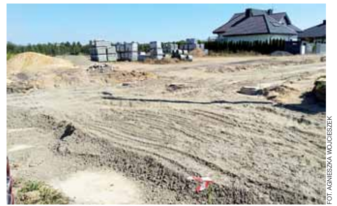
W tym miejscu prace modernizacyjne nadal trwają. Widok na ul. 11 Listopada od strony ul. Rataja.
