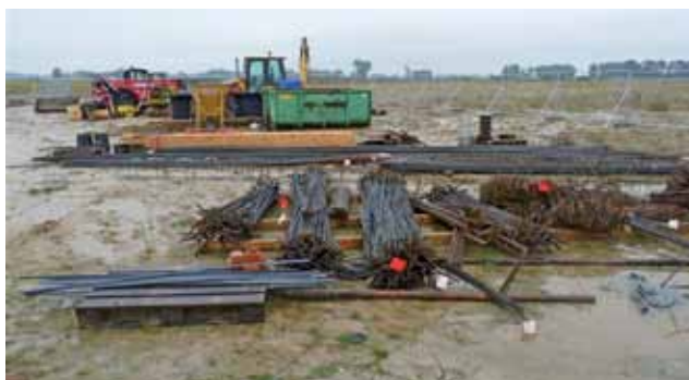
Opuszczony plac budowy w Piaskach Bankowych. Stan na 22 września 2017 roku.
