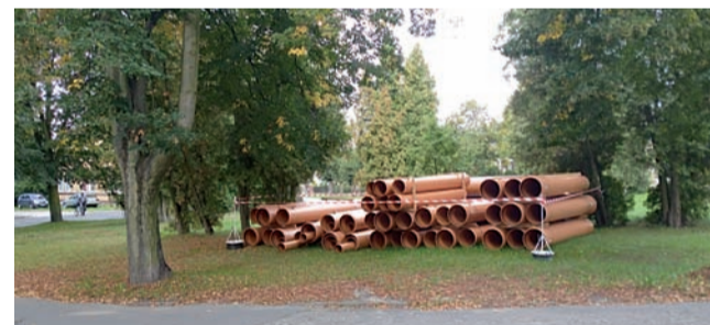
Plac Reymonta w Głownie. Już widać, że będzie się tu coś działo.
