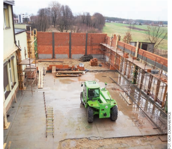
Na tym zdjęciu, które zostało wykonane kilka miesięcy temu, widać o jak dużą część został rozbudowany ośrodek.
