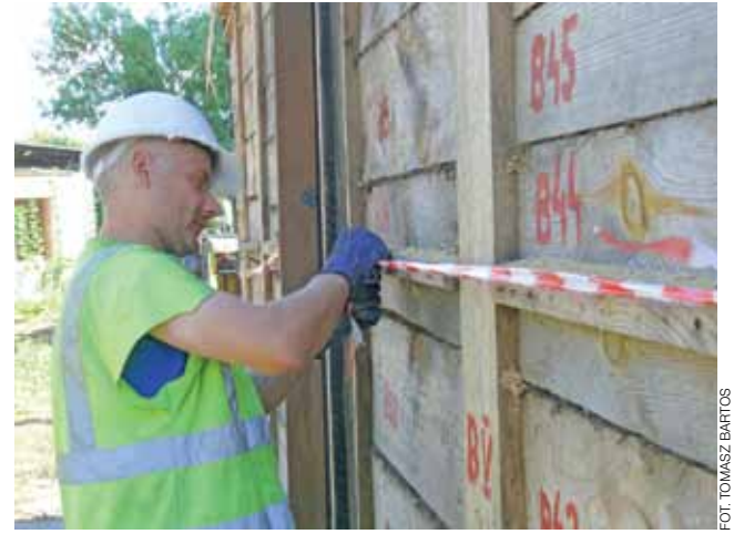
Drewniany budynek przy ul. Bolimowskiej jest w trakcie rozbioru, o niebezpieczeństwie ostrzega białoczerwona taśma.
