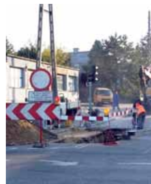
Prace już się rozpoczęły, dlatego ul. Szkolna jest wyłączona z ruchu.
