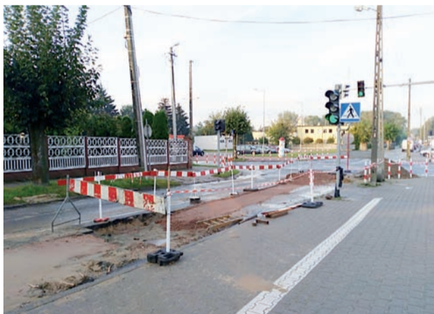
Prace przy ul. Szkolnej wciąż postępują. Stan na 7 października.
