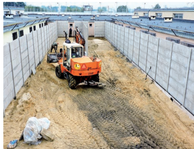
Na tym etapie prac wyraźnie widać już zarys kształtu przyszłego placu spacerowego.
