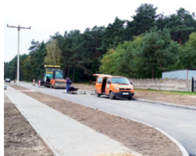
Koniec już blisko. Stan ul. Ułańskiej na śróde – 21 października.
