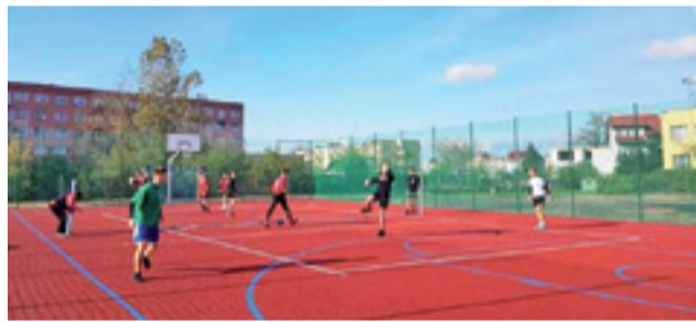
W listopadzie ubiegłego roku zakończono I etap budowy boiska przy II LO. W przyszłym roku, dzięki licznym głosom w budżecie obywatelskim, kompleks zostanie rozbudowany.
