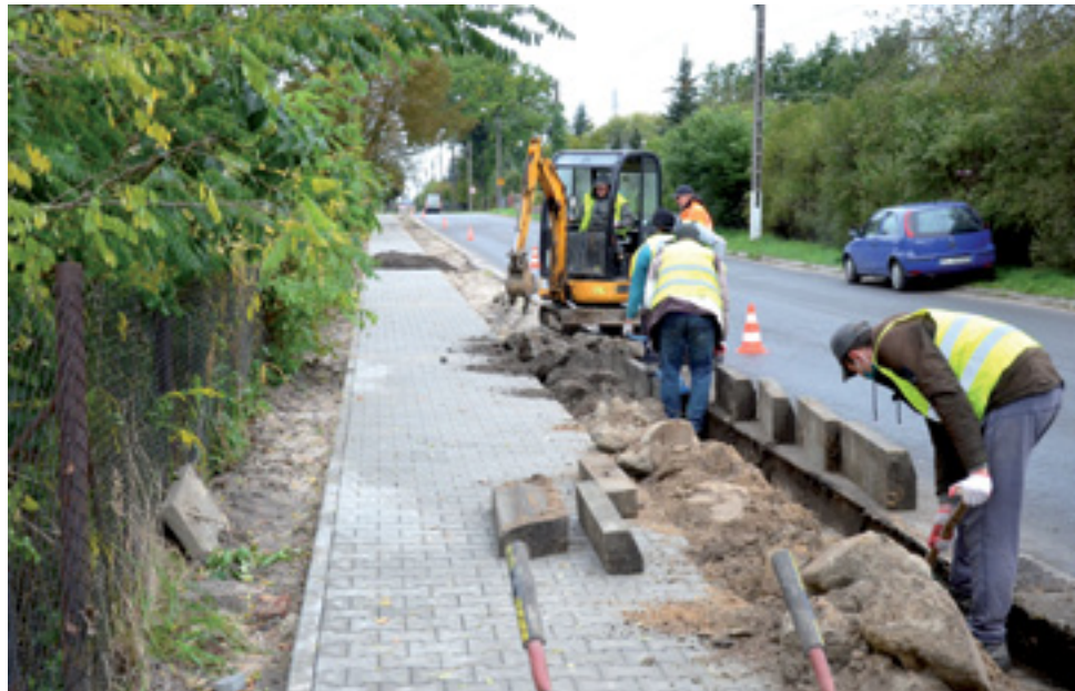
Budowa chodnika przy ul. Kolejowej w Strykowie.
