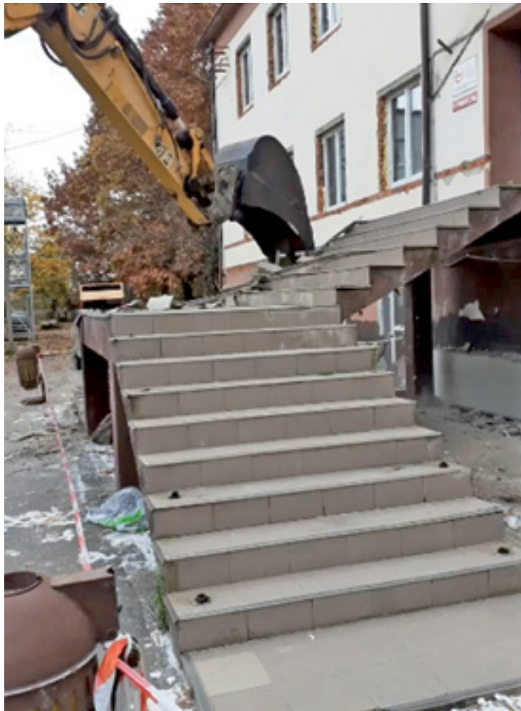
Rozbiórka starych schodów do głównego wejścia starszego budynku.
