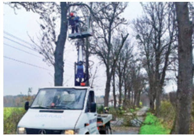
Roboty wzdłuż drogi w Woli Błędowej w gminie Stryków.
