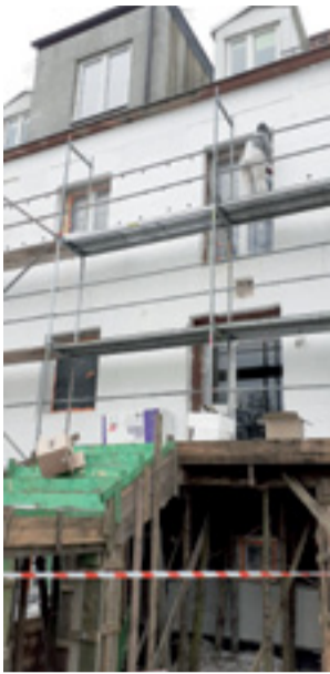
Budynek jest już prawie w całości docieplony.
