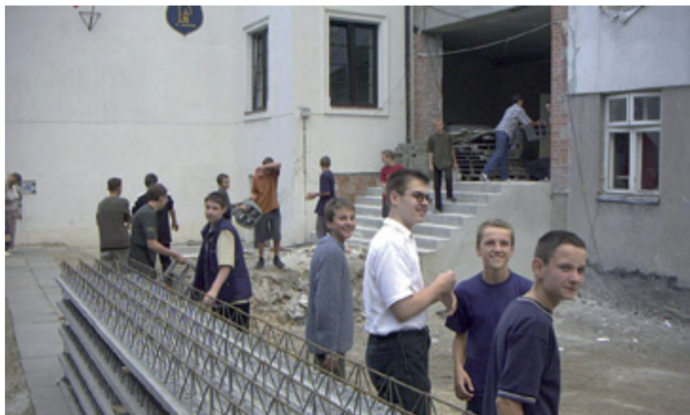
11 września 2002 r. Uczniowie szkoły pijarskiej pomagali rozładowywać pustaki na strop rozbudowywanej szkoły.
