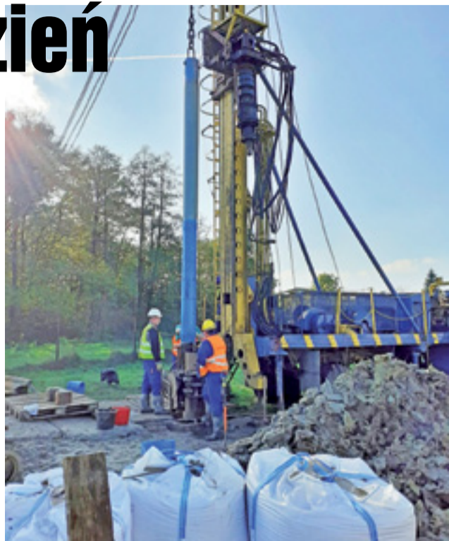
Studnia jest już wywiercona, teraz trzeba ją podłączyć do hydroforni i ponownie zbadać wodę przed puszczeniem jej w obieg.
