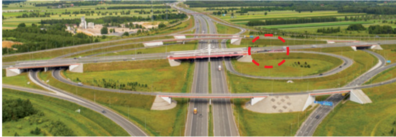
W centrum fotografii unieruchomiony wiadukt (wycofano ruch z jezdni w kierunku Katowic, na zdjęciu z lewej na prawą). Obok, oznaczone czerwonym kółkiem, miejsce, w którym samochody kierowane łącznicą na Warszawę wracają na główną jezdnię.
