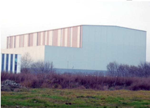
Nowoczesny magazyn wysokiego składowania ZPOW Agros Nova – widok od ul. Kaliskiej.
