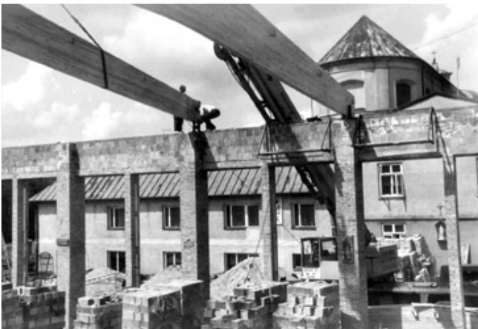
Maj 1998 r. Prace przy budowie sali gimnastycznej dla szkoły pijarskiej.
