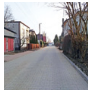
To efekt prac, które w ostatnim czasie prowadzono przy ul. Wyzwolenia i Andersa.
