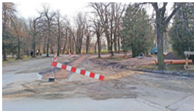
Pod koniec ubiegłego tygodnia prace przy rondzie wciąż były prowadzone, ale z każdym dniem utrudnień było coraz mniej.
